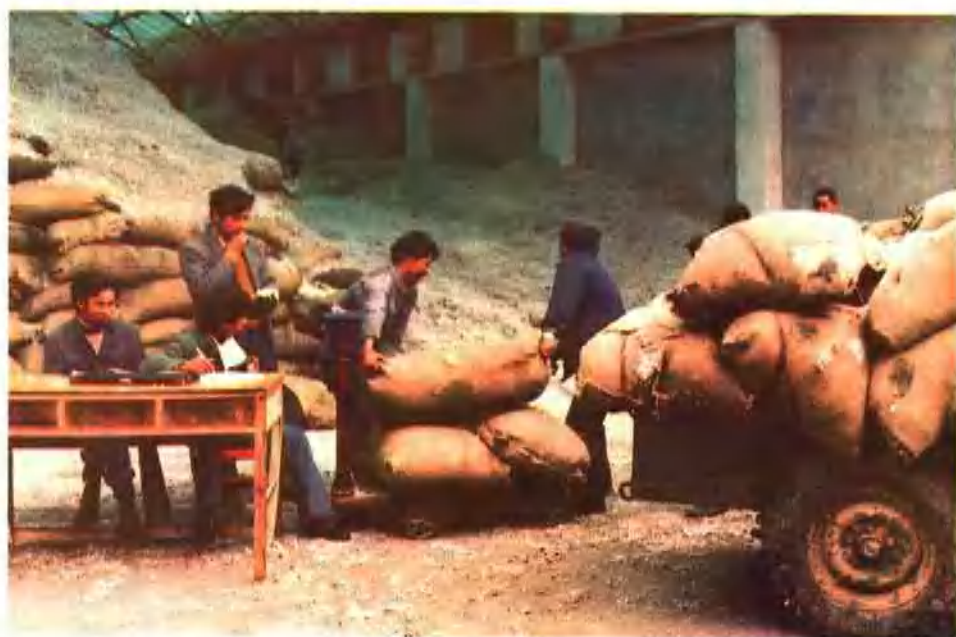
团风油厂原料车间
