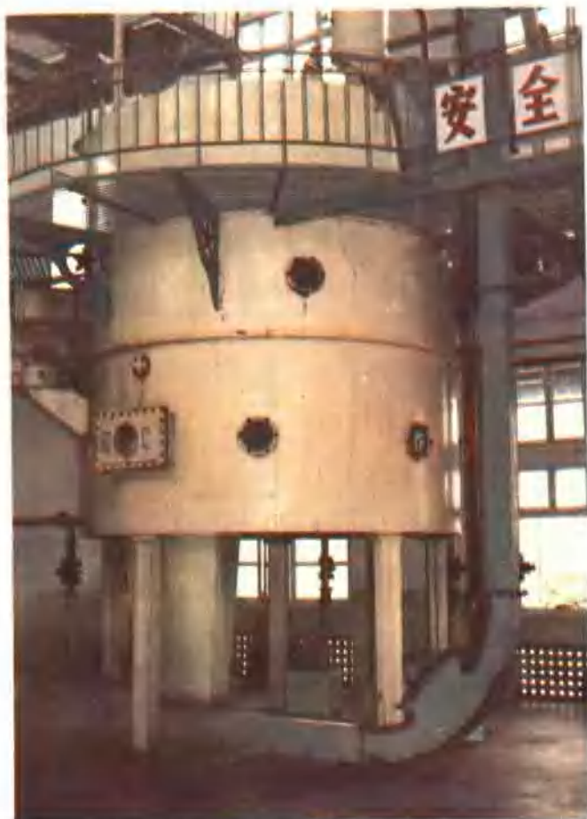
团风油厂浸出油车间
