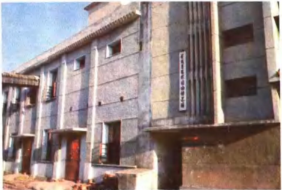
团风粮油储运站
