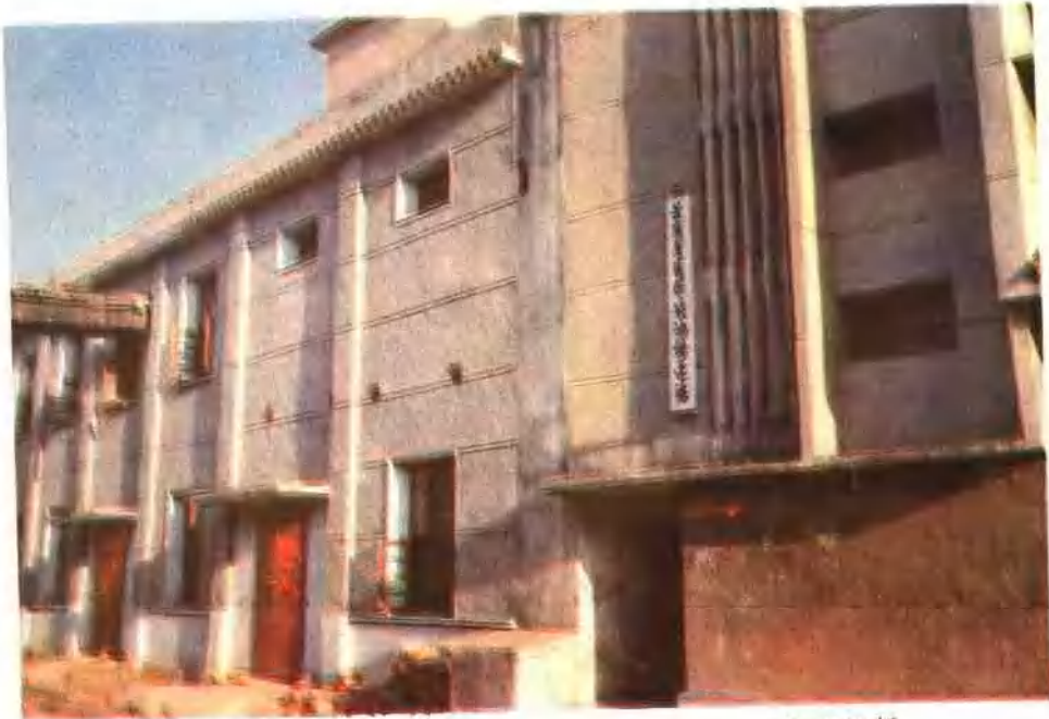
团风粮油储运站
